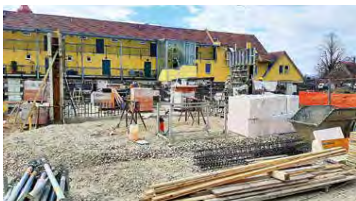
Die Bauarbeiten für die ...
