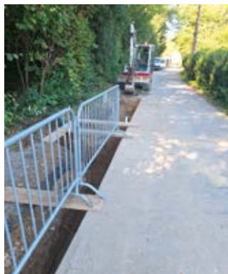
Am Katzelnbach werden die Stromleitungen erneuert.
